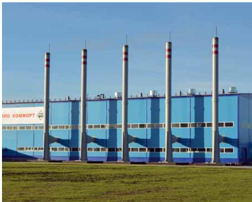
СОВРЕМЕННАЯ КОТЕЛЬНАЯ В ПОСЁЛКЕ ОКТЯБРЬСКИЙ
